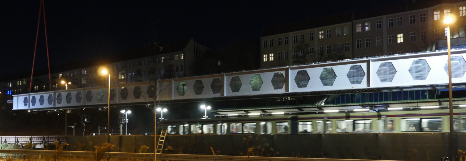
Montage final d'un pont de canalisation sur l'installation ferroviaire du réseau de la DB (Deutsche Bahn) AG (©IBG)
